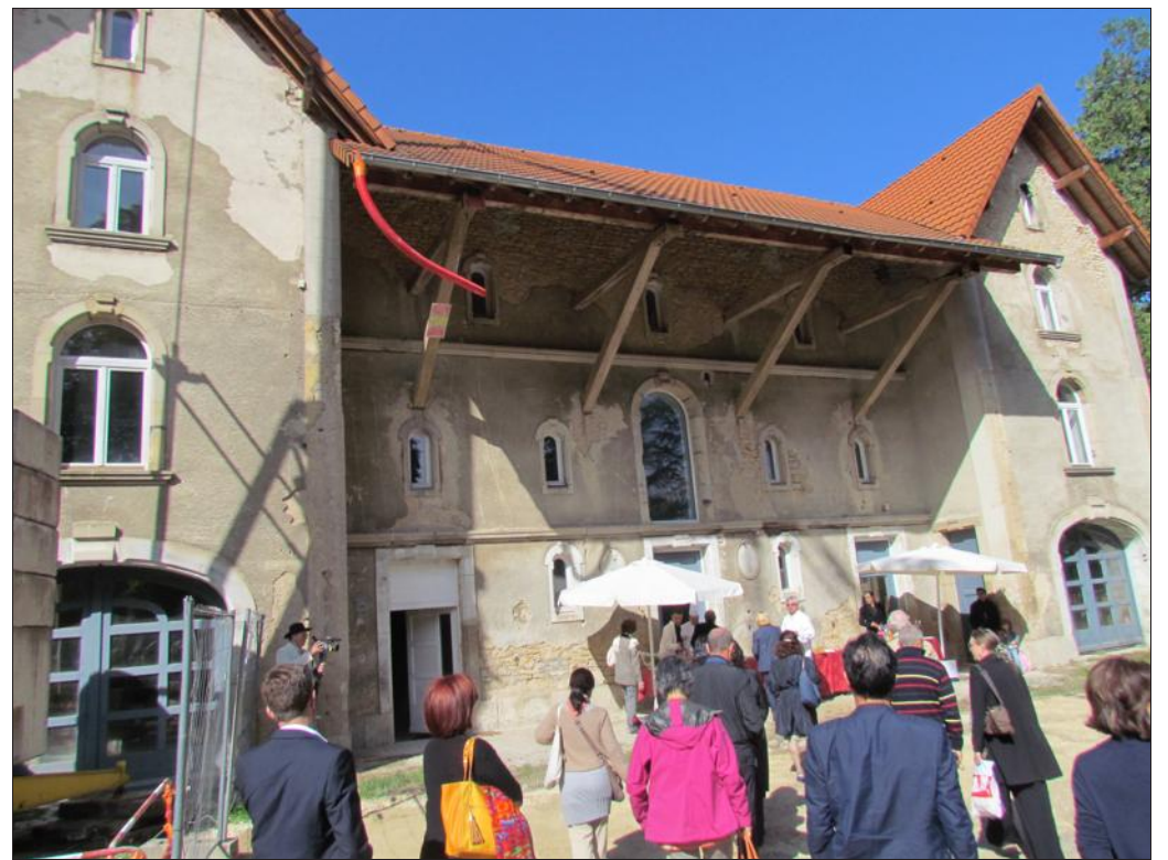
■ Les anciennes écuries abriteront un centre de séminaires et un restaurant.
